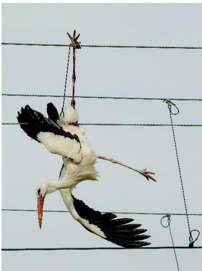
Verunglückter Weißstorch in Oberleitung © B. Steiner
